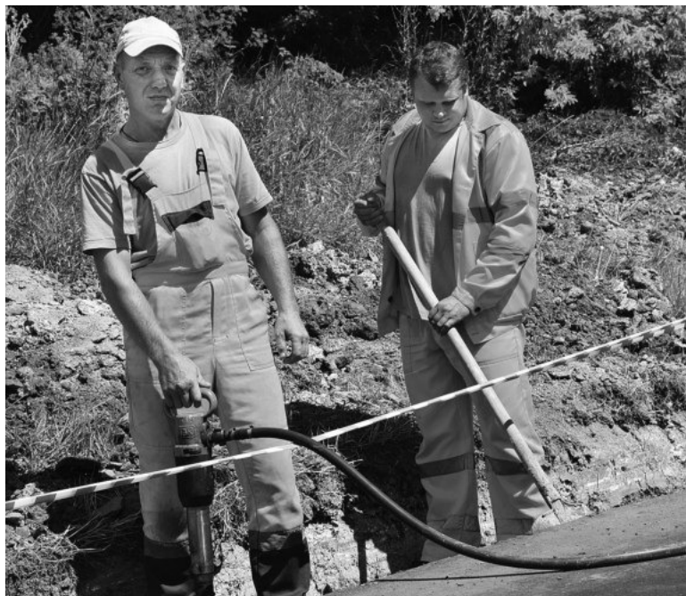
Дорожные рабочие Александр Плахотин и Иван Чернявских ведут обустройство основания для водоотводных лотков
