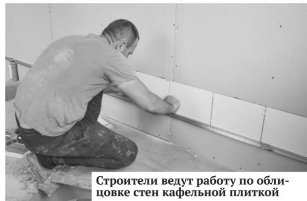
Строители ведут работу по облицовке стен кафельной плиткой
